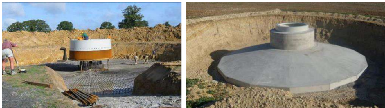
Photo 6 : Le ferrailage et le coulage d'une fondation d'éolienne
